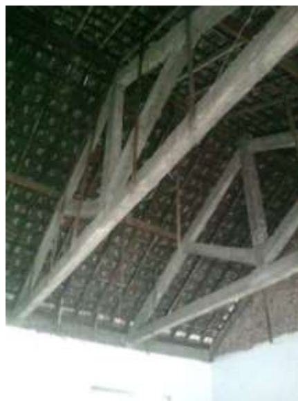
Kondisi Atap Ruang kelas II
