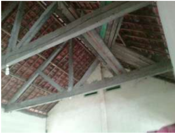
Kondisi Atap Ruang Kelas I
