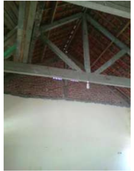
Kondisi Atap Kelas I
