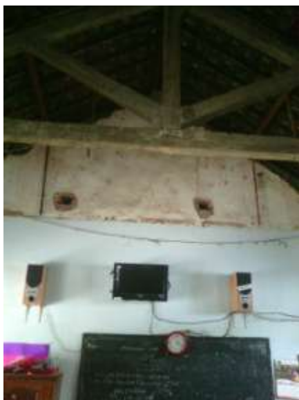
Kondisi Atap Ruang Kelas II
